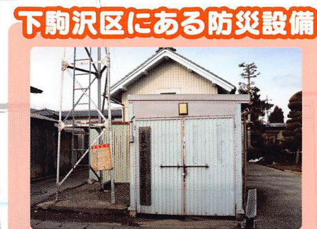
消防ポンプ置場
