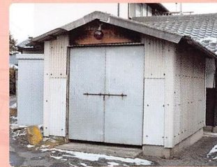
消防ポンプ置場
