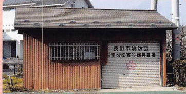
消防ポンプ置場
